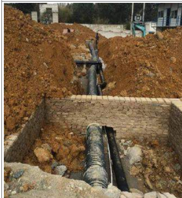
排污水管道埋设
