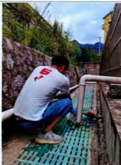
污水处理设施排口
